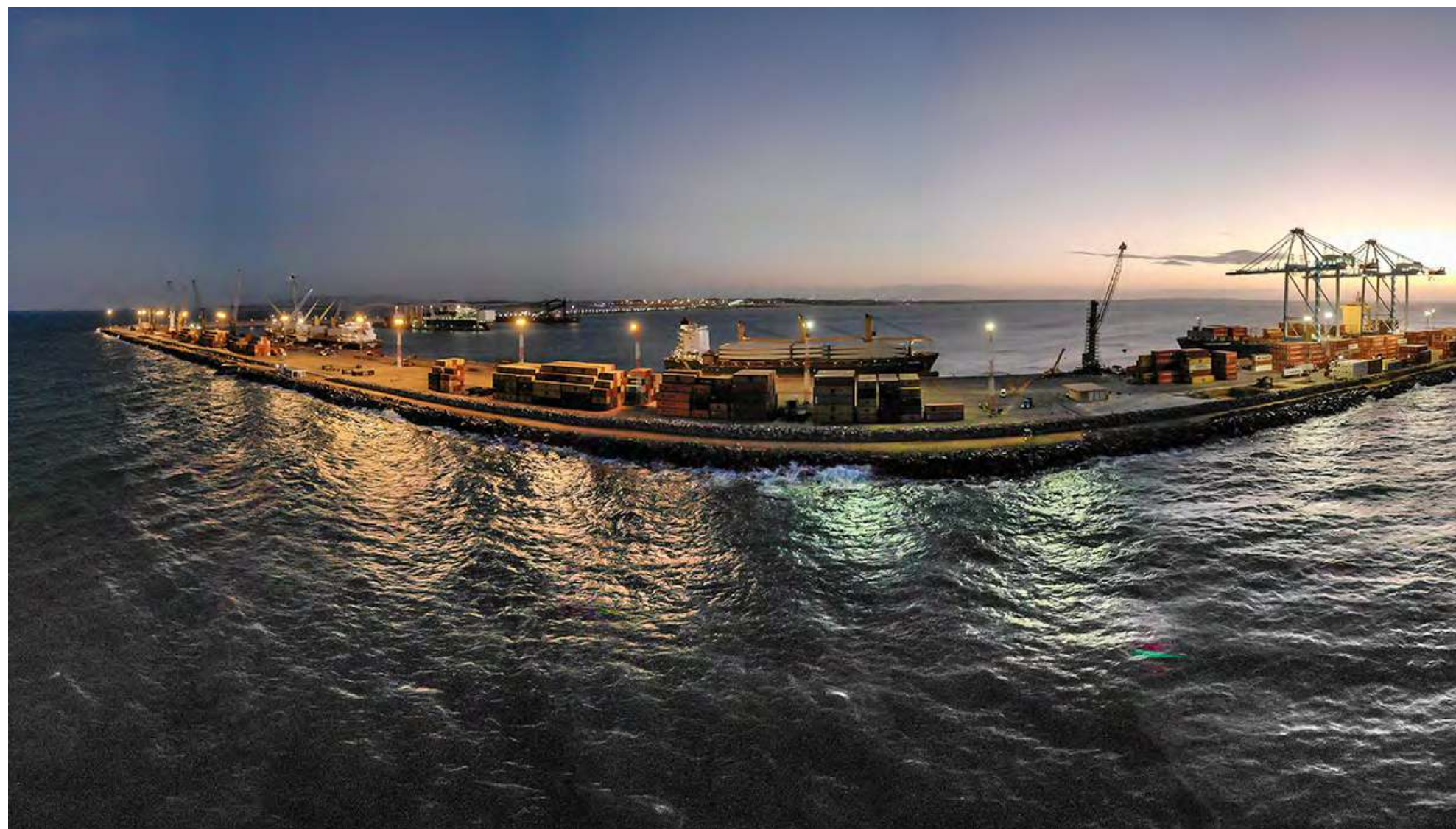
Obra de ampliação do Porto do Pecém (Ceará)
