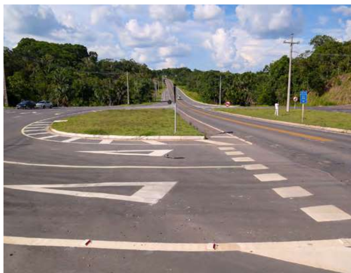
Urbanização e pavimentação da rotatória e vias de acesso ao CTTR de Manaus.
